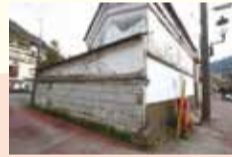
〈萬翠楼福住・福住正兄3 MAP⑪〉福住正兄は明治8年、いち早く小田原湯本間に車道を整備。旅館も木骨石造りの擬洋風建築として、二階までの壁を石積みで囲い、火事の多かった湯本の防火対策として各旅館に石造りの蔵を作らせたりしました。
